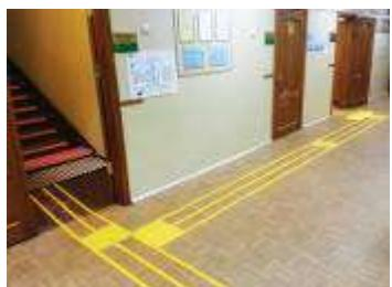
Специальные объемные тактильные плитки и другие варианты напольных тактильных покрытий (например, встраиваемые направляющие полосы и биты) формируют рисунок, позволяющий незрячим людям получать информацию о безопасном пути движения (направления движения, повороты) и о наличии препятствий на пути движения (пороги, перекрестки, ступени,
