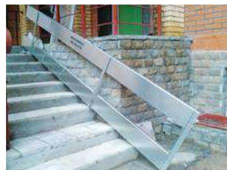
Направляющие такого пандуса жёстко скреплены между собой внизу и вверху. Вся конструкция крепится вертикально к стене или перилам, идущим вдоль лестницы, при помощи петель, щеколд и прочих замков. Также используются для облегчения доступа людей с ограниченными возможностями в общественный транспорт (например, автобусы).
