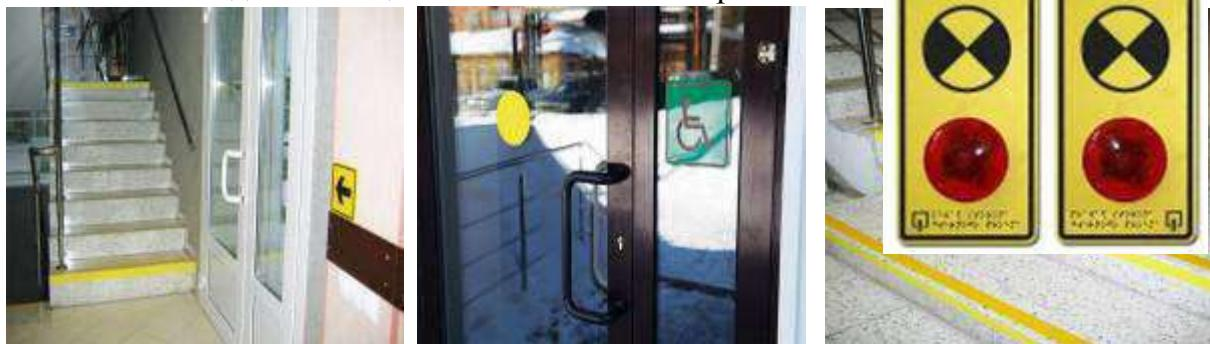
предназначены для контрастного выделения дверного проема. Устанавливаются на высоте полутора метров с левой и с правой сторон двери. Данными световыми маяками обозначается выход из помещения. При необходимости можно обозначить любые другие дверные проемы.
